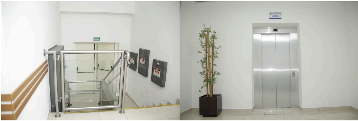
Figura 5 – Rampa de acesso e elevadores
